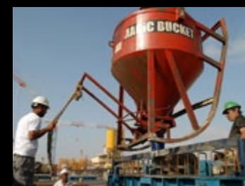
Pouring a New Jersey element
